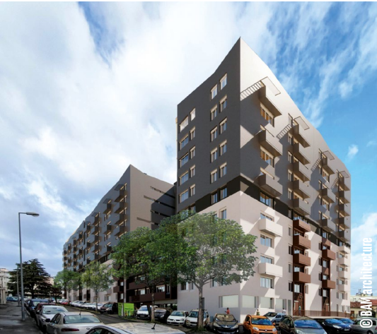
À Nîmes, la résidence Le Vulcain entre dans une nouvelle ère énergétique : grâce à un système collectif de géothermie, Un Toit Pour Tous remplace le gaz par une énergie décarbonée, alliant confort, performance et réduction des émissions de CO 2 .
